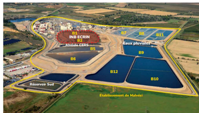
Cliché 1 - Vue aérienne du site Orano de Malvési issue du rapport d'information du site [7]. Les bassins industriels et les zones identifiés sur ce cliché sont décrits dans les paragraphes suivants.
